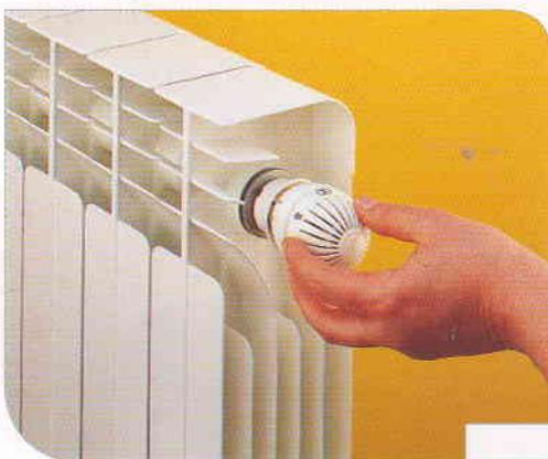
4. Таким образом, головка уже установлена и может быть открыта до нужного положения.
