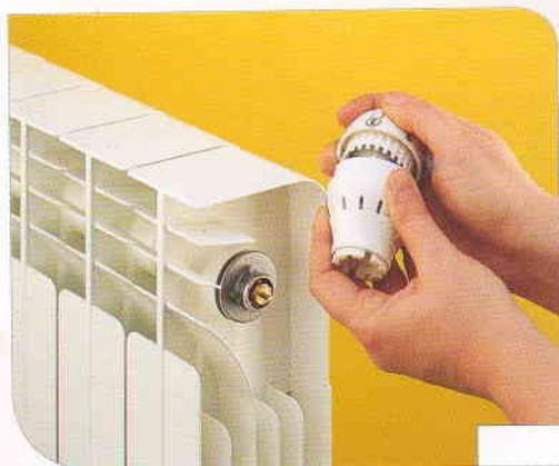
1. Переведя ручку в желаемое положение, снимите ее, вытянув ее вперед или при помощи соответствующего инструмента. Во избежание потери калибровки термостатической головки, ни при каких условиях нельзя менять
